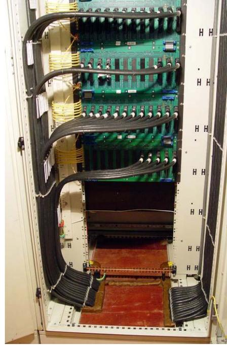
图七：计算机电缆敷设及防火封堵工艺样板图
