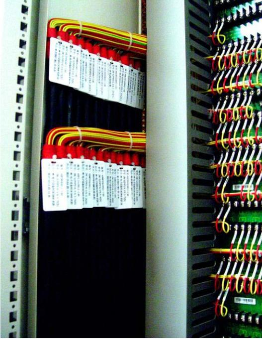
图六：盘内电缆绑扎样板图
